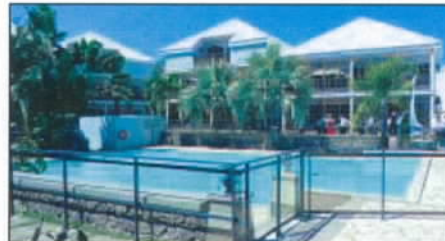
Des groupes de travail interministériels sur la rénovation des hôtels notamment devraient être mis en place dans les prochains mois.
